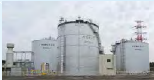
▲消化タンク・ガスタンク
