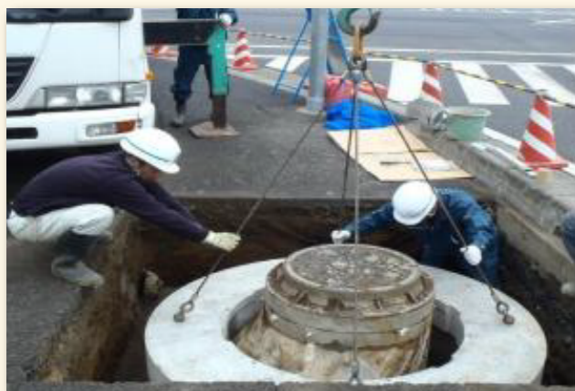
マンホールの耐震化
